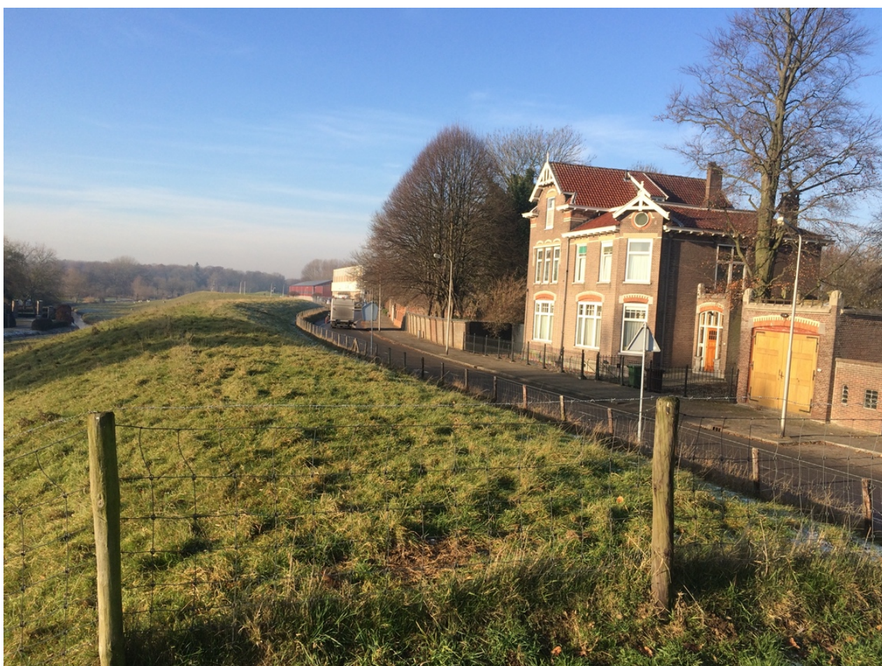
Figuur 3.23: Voornamelijk kleinschalige bebouwing in een groene omlijsting aan de Ringdijk t.h.v. Slikkerveer
